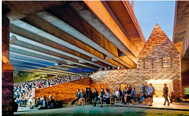
Gestaltete Aneignung I: Folly for a Flyover, Architektenkollektiv Assemble aus London, 2011. Eine ungenutzte Autobahnunterführung in Hackney Wick wurde in einen Treffpunkt für Kunst und Kultur transformiert. Als Kollektiv treten die Architekten in den Hintergrund; Die Umsetzung basiert auf Mitarbeit und Eigenleistung der Passanten und Anwohner. (Fotos: Assemble)
